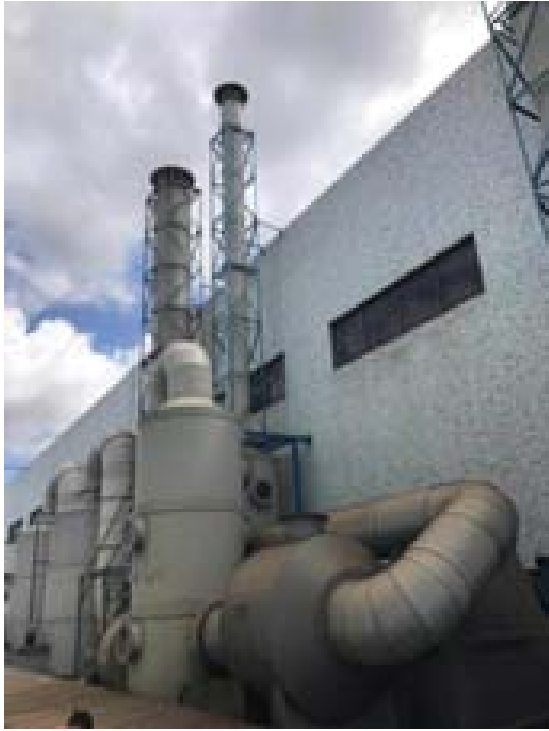
大气浓缩回收系统（5#卧镀线）
