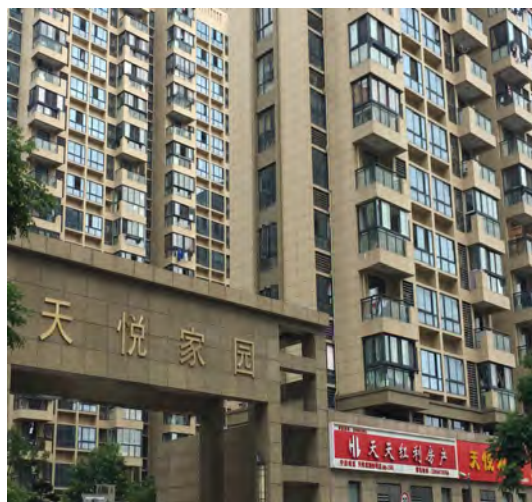
(冯家安置房) 地块北面
